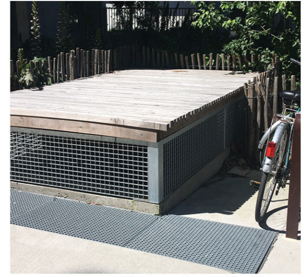
Aération parking rue Magdeleine Nantes
