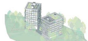
une intégration végétale qui se développe du R+0 à la toiture en passant par l'aménagement possible des balcons par les usagers
