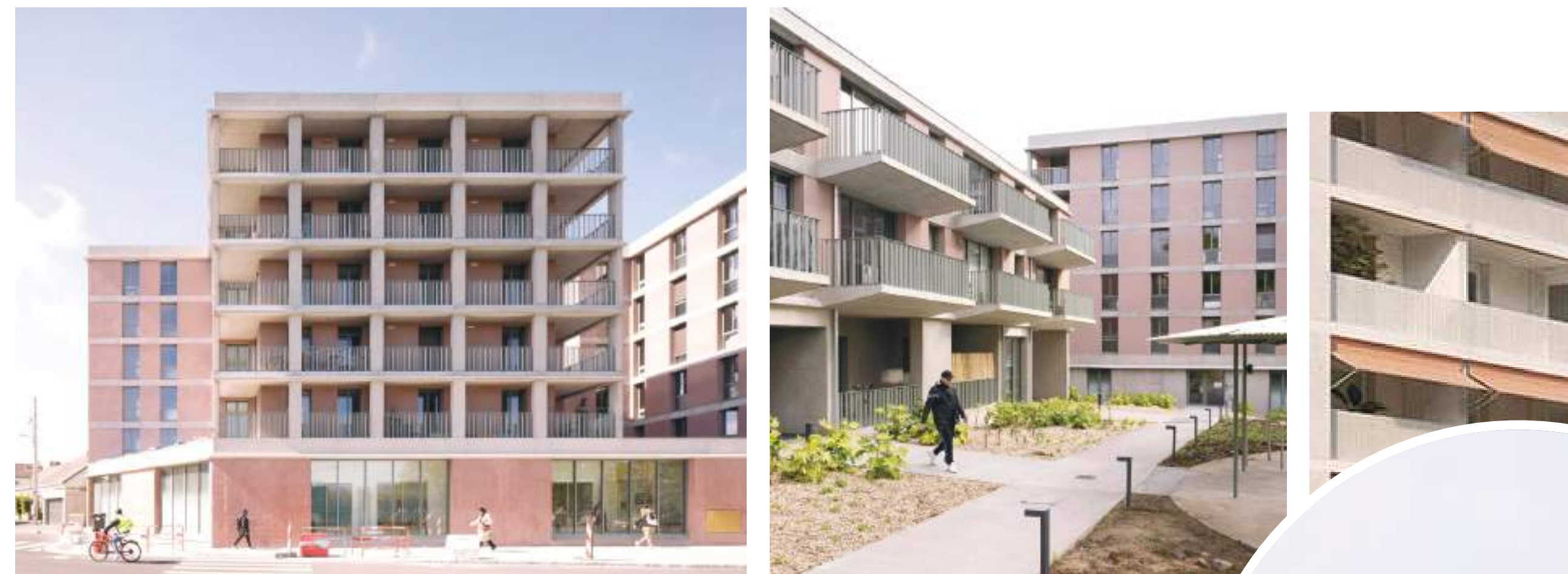
Dispositifs de loggias en façade Est, et de balcons jouant le rôle de casquette en façade Sud
